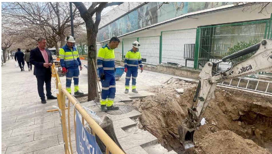
Visitas a las obras del hundimiento. - Ayuntamiento de Jaén.
