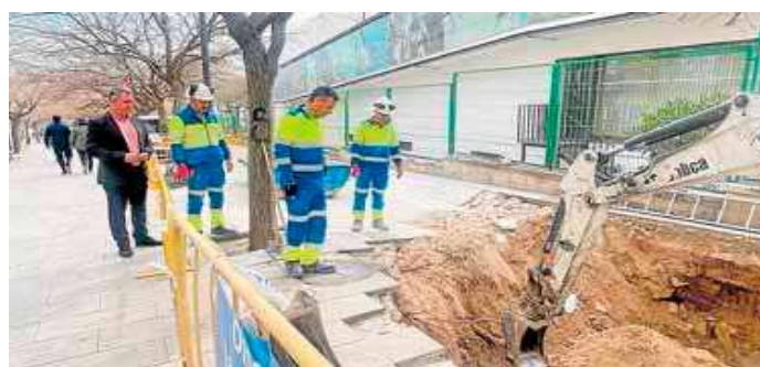
Obras acometidas en la Avenida de Granada. IDEAL
